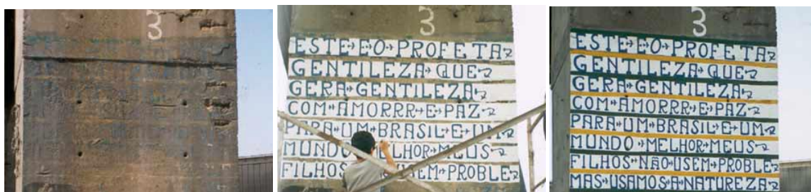
Figura 2 - Pilastra 3, Antes, Restaurando e Restaurado. 16
